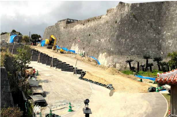
工所用仮設道路設置（イメージ）
