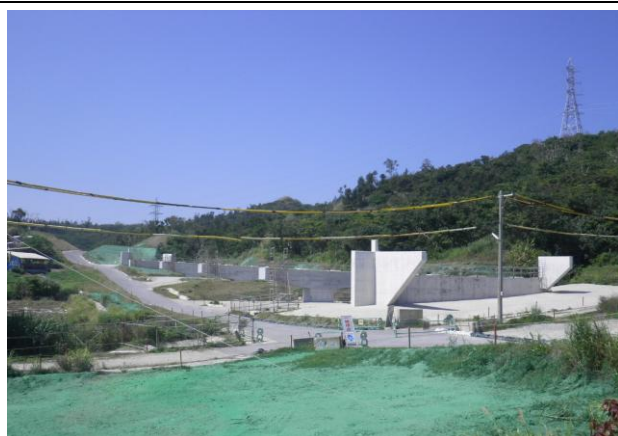
1 号橋 (橋台 2 基、PC 梁橋脚 3 基)
