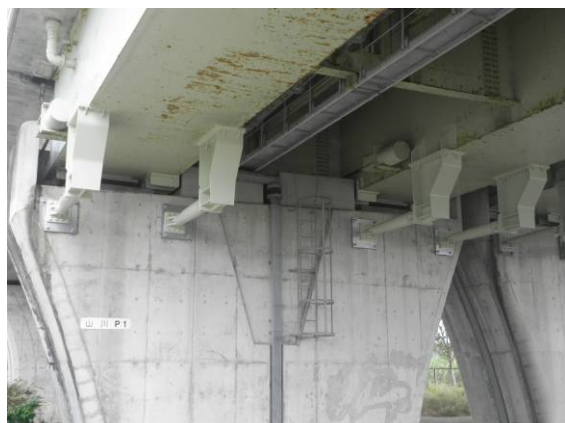
落橋防止装置工(制震ダンパー)
