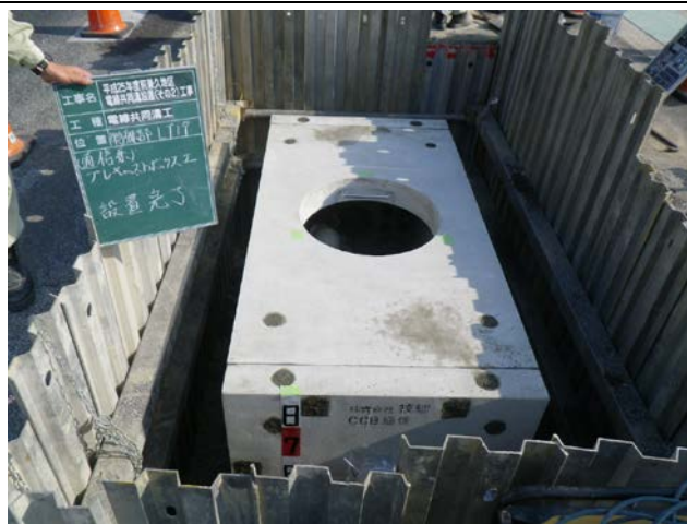
電線共同溝工・通信特殊部設置状況
