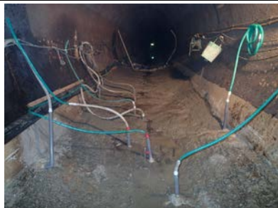
インバート部 湧水処理状況
