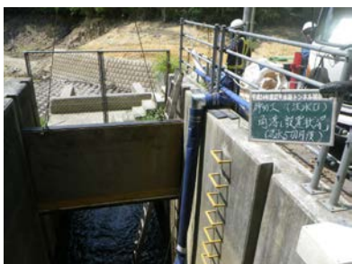
仮締切工（送水に伴う角落し設置・撤去）
