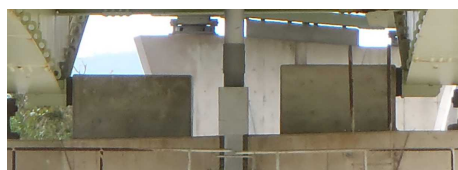
落橋防止工(RC 突起)
