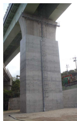
橋脚コンクリート巻立て工
