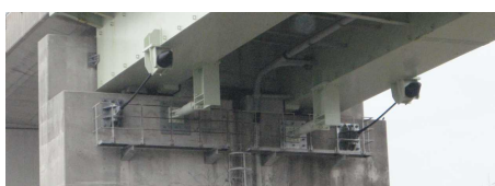
落橋防止工(制震ダンパー、PC ケーブル)
