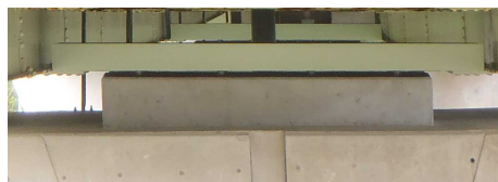
落橋防止工(縦型ピン)
