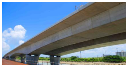
海側下り線 A1-P3 張出の 3.5 径間 施工延長:253.0m
