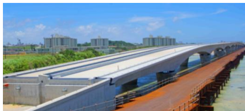
海側下り線 A1-P3 張出の 3.5 径間 施工延長:253.0m
