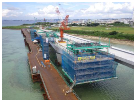
移動作業車による施工状況
