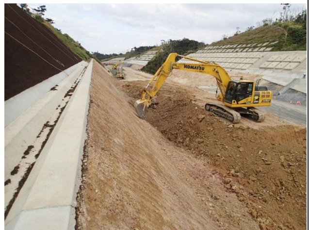
MC バックホウによる法面整形
