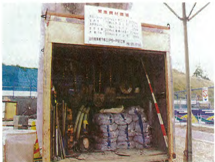
緊急資材置場の例
