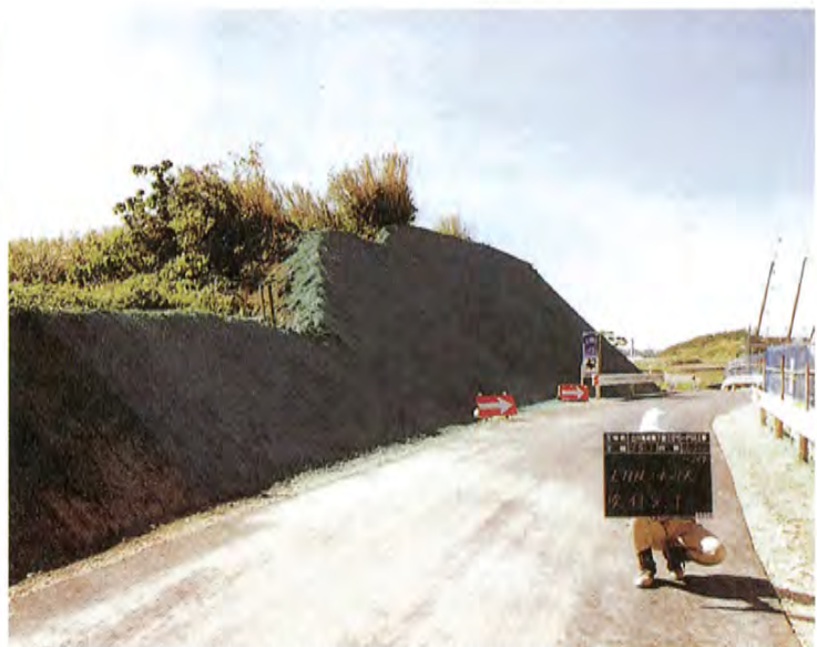
沖縄総合事務局南部国道事務所発注 山川高架橋法面 施工直後の様子。 仮設の切土のため養生シートの変わりに施工した。手前の乳剤は、1ヵ月たらずで浸食された。 EMNコート21Rは10ヵ月後でも法面保護として効果を発揮しています。
