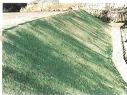
吹付3日後、大雨が降り続いたが土壌、種は流れる ことなく発芽は良好でした。
