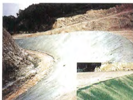
沖縄県中部土木事務所 発注 石川仲泊線。 土捨場吹付後の様子。
