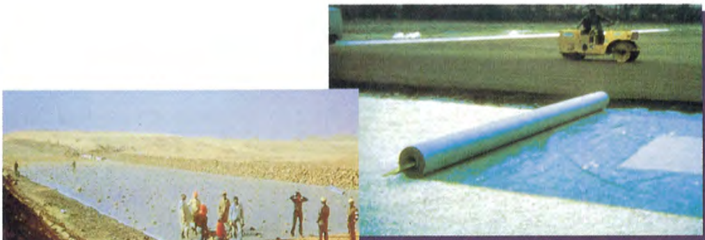
グラウンドの土層分離
