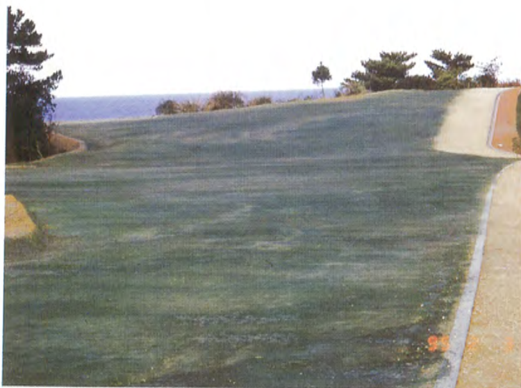
県道石川仲泊線道路改良工事（赤土流出防止施工）
