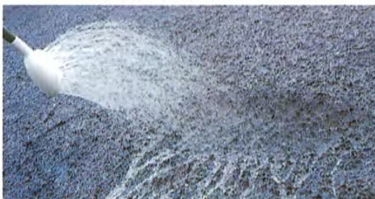
雨を想定しての散水状況。水を弾いているのがわかる。
