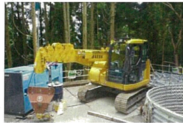
クローラークレーン
