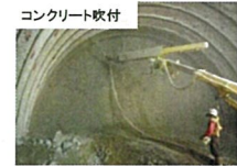
コンクリート吹付
