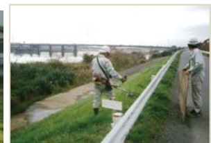
機械除草(肩掛け式:飛石防護有)
