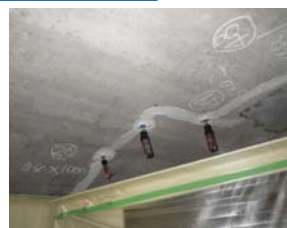
低圧注入器具による注入状況
