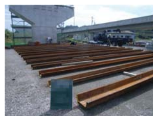
基礎用鋼材設置
