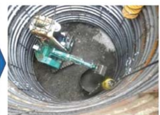
小型バックホウ(電動式 山積0.03m 3 )
