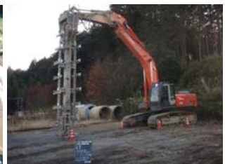
中層混合処理機(ヘースマン1.4m 3 級)
