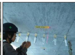
低圧注入器具による注入状況
