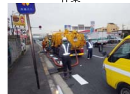
管渠清掃作業
