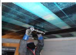
炭素繊維シート接着状況
