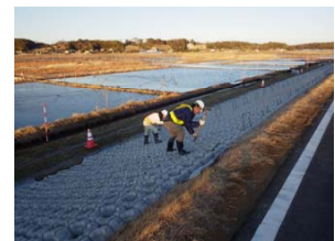
アンカーピン打設状況
