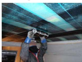
炭素繊維シート接着状況
