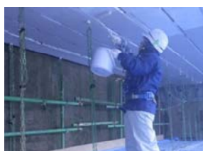
仕上げ塗装状況
