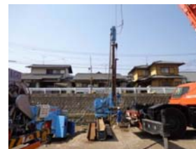
鋼矢板圧入状況
