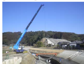
ブロックマット据付状況
