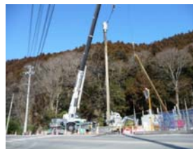
鋼矢板吊り込み状況
