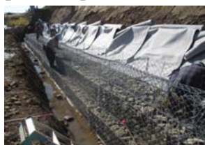
かご組立・据付状況
