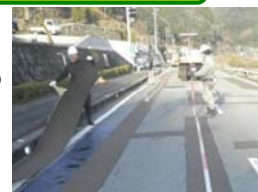
クラック防止シート張り作業
