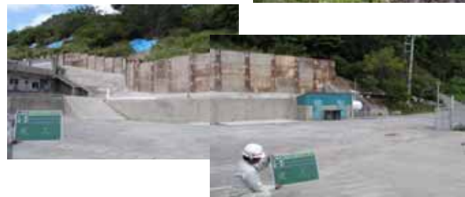
仮設施工後の状況
