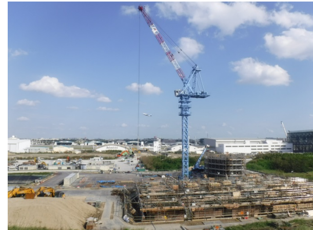
③ 管制塔工事 施工状況 (平成29年12月撮影)
