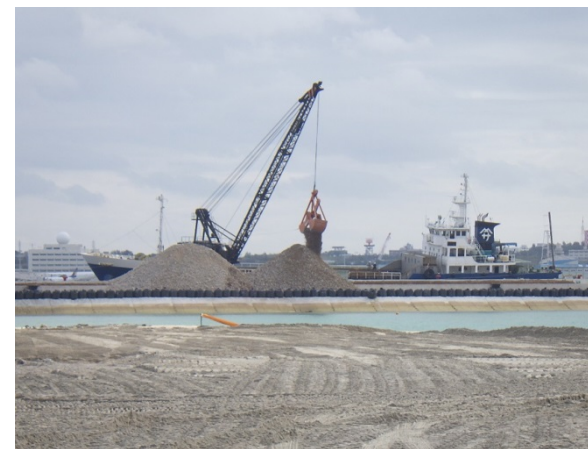
③ 【IV工区】海砂揚土状況 (平成29年11月撮影)
