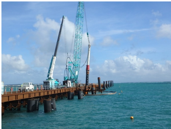
① 南側進入灯工事 杭打設状況 (平成29年8月撮影)
