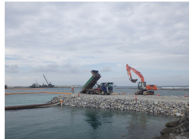
③ 【V工区】捨石投入状況 (平成29年11月撮影)
