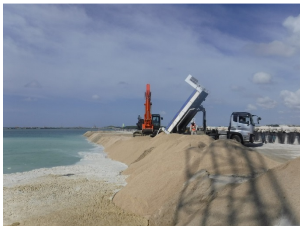
① 【I工区】海砂投入状況 (平成29年10月撮影)
