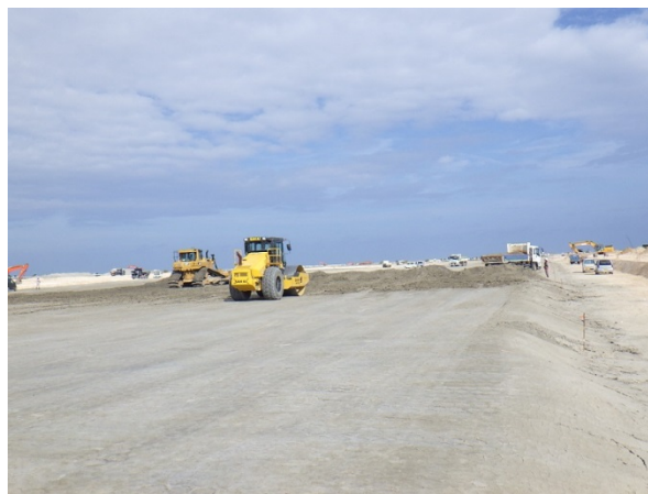
② 【II工区】改質土敷均し状況 (平成29年11月撮影)
