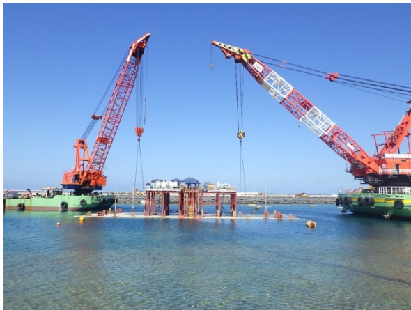
① 【V工区】通水カルバート据付状況 (平成29年8月撮影)
