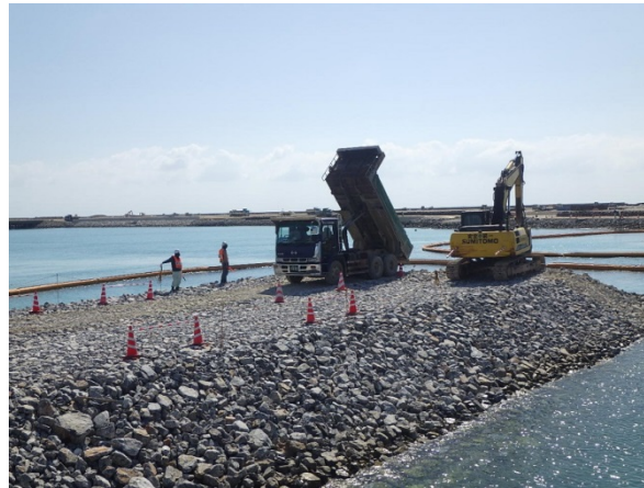
② 【V工区】捨石投入状況 (平成29年9月撮影)
