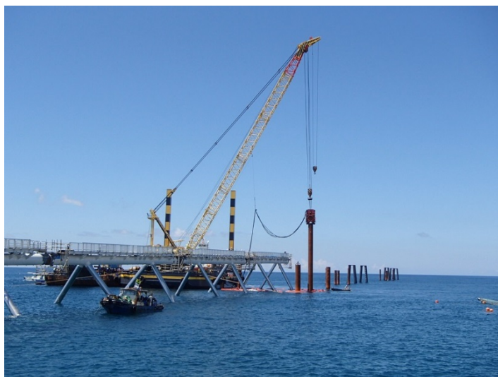
① 【北側進入灯】平成29年8月撮影
