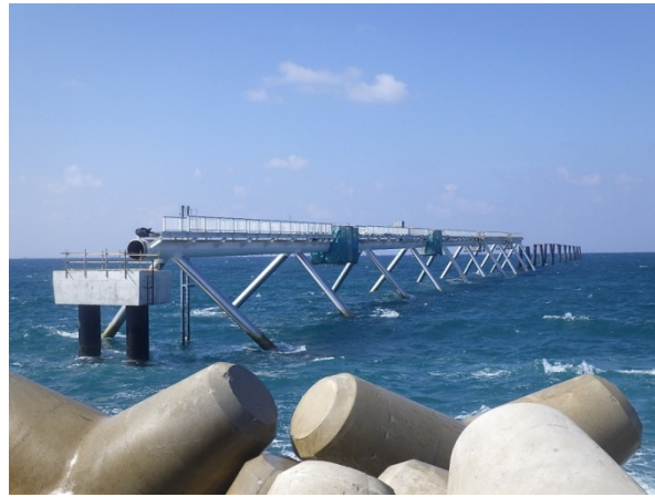
② 北側進入灯工事 現場全景 (平成29年10月撮影)
