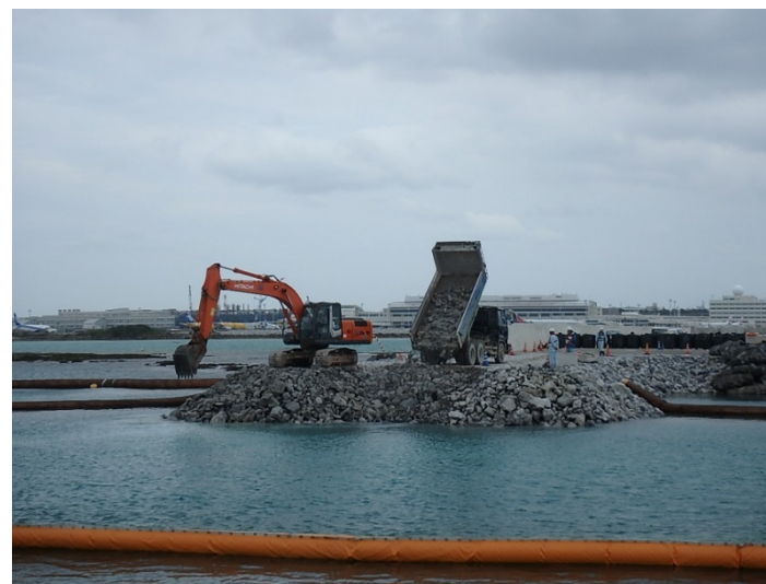
② 【V工区】平成29年11月撮影
