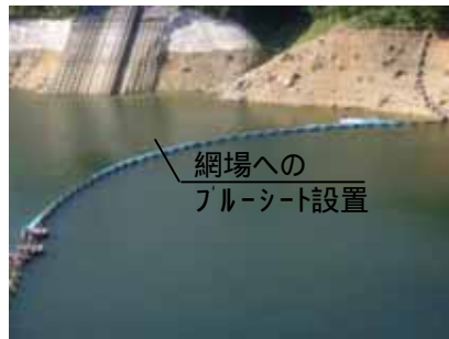
流出移動経路の阻害対策 (施工後)
