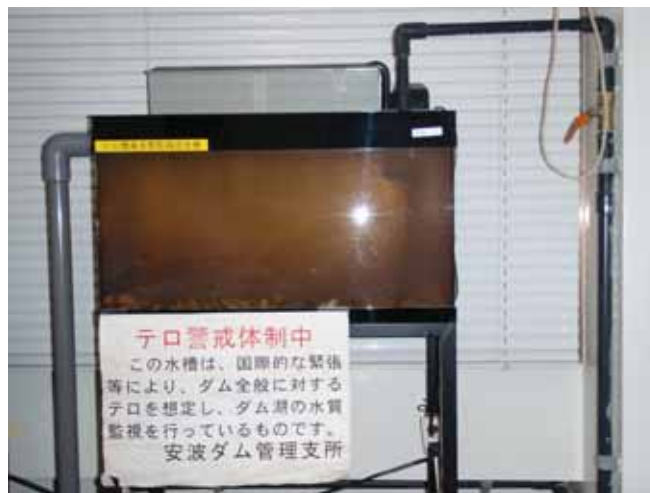
安波ダム貯水池の水質監視用の水層
