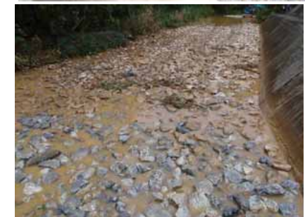
礫材投入による 産卵場の浅場化 (上: 施工中、下: 施工後)
