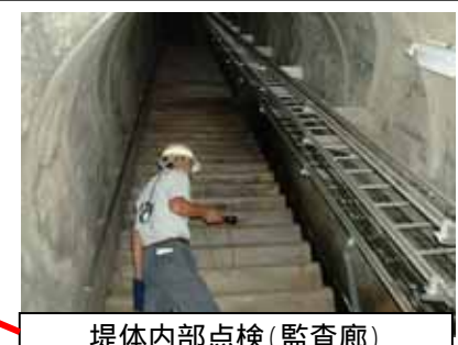
堤体内部点検(監査廊)
