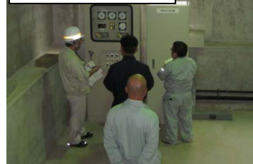
ゲート操作盤点検
