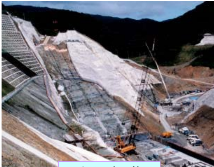
羽地ダム建設状況
