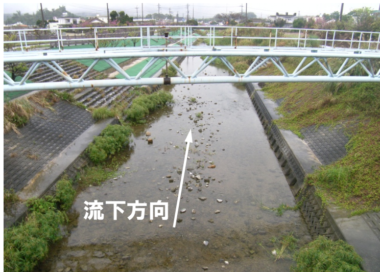
稲搦橋地点下流の現況
