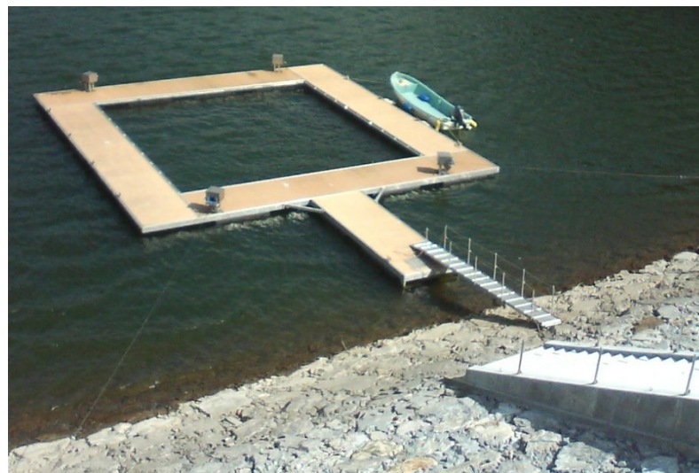
羽地ダムの水質監視用の生け簀
