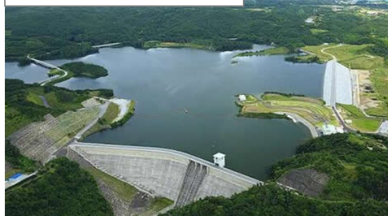
ダム貯水池全景
