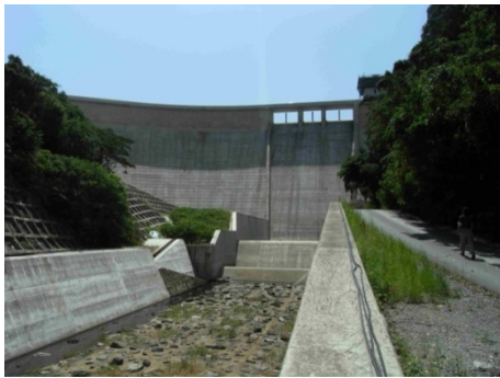
ダム下流減勢工
