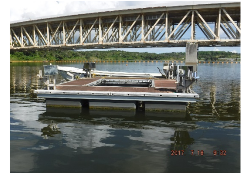
水質監視用の生け簀(貯水池内)
