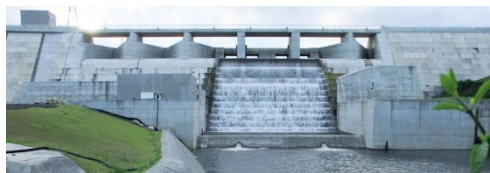
①ダム下流減勢工
