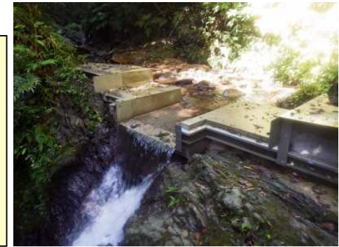
アオバラヨシノボリ保全対策工 (平成28年1月完成)
