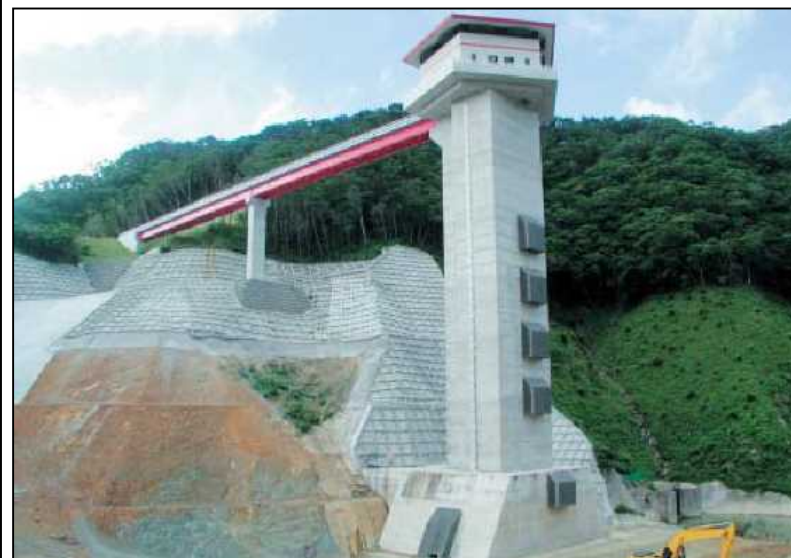
取水設備全景
