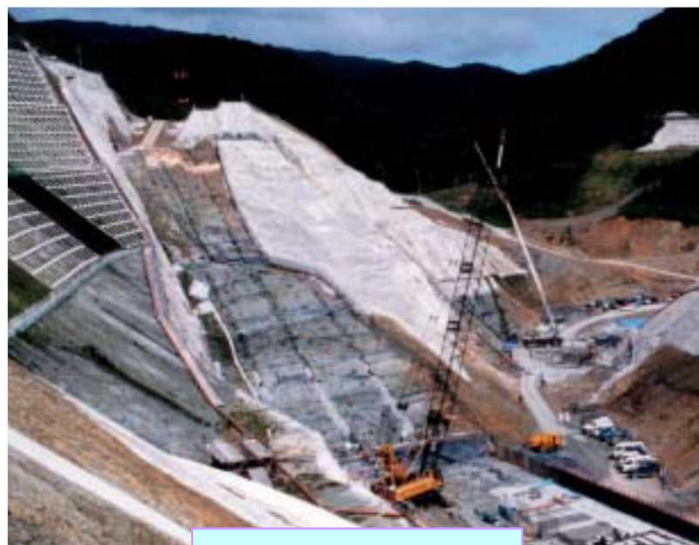
羽地ダム建設状況
