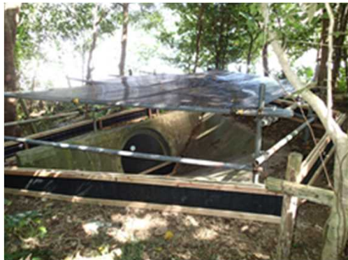
H28.3コウモリボックス修繕状況
