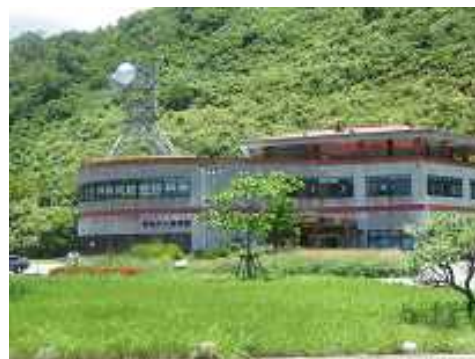
管理棟 (ダム資料館)
