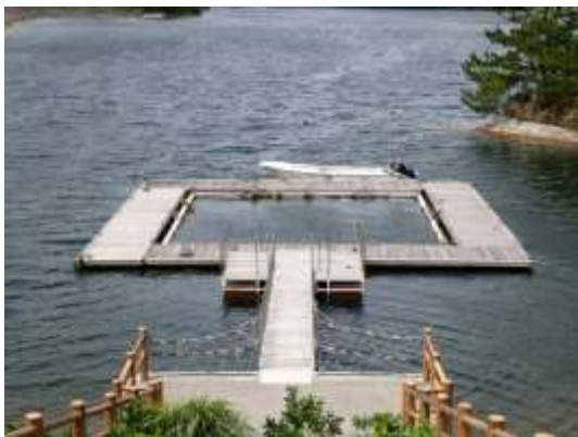
水質異常・テロに対するモニタリング用生け簀(漢那ダム貯水池)
