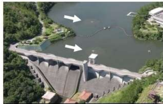
曝気循環装置による曝気の様子
