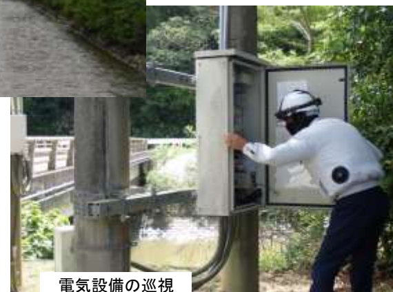
電気設備の巡視
