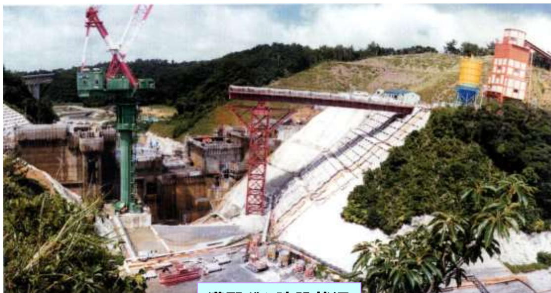
漢那ダム建設状況
