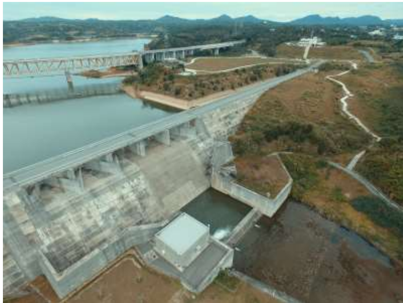
金武ダム全景
