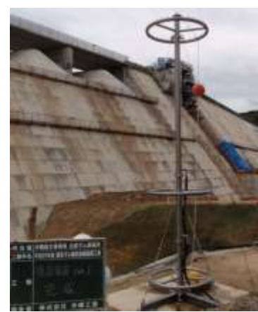
気泡式循環施設設置状況
