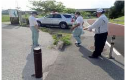
点検状況(R3.4.26)
