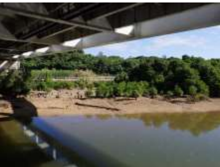
工事個所周辺に植栽されたマングローブ
