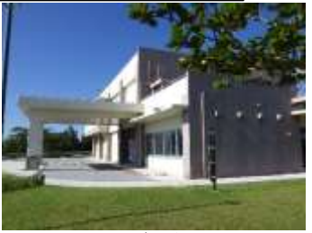
金武ダム資料館
