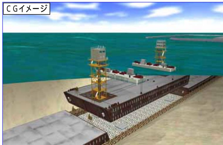
自動追尾距離計、水中距離計など最新システムを使用し、函体位置を正確に確認しながら6号函と8号函の間へ慎重に沈設します。
