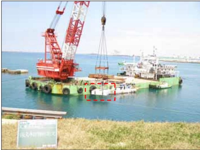
沈埋函に取り付けている支承ジャッキのロッドを受ける台座を据え付けます。
