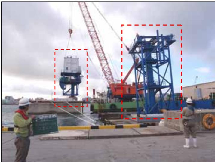
沈埋函の曳航・沈設時に司令塔となるタワーやポンツーン(箱形浮体)等を取り付けます。
