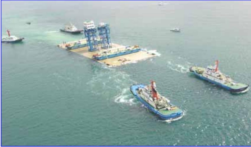
4隻の曳船で沈埋函を曳航します。一般船舶の航行に妨げにならないように、連絡を密に取り作業を実施します。（3号函の曳航状況、平成15年10月2日撮影）
