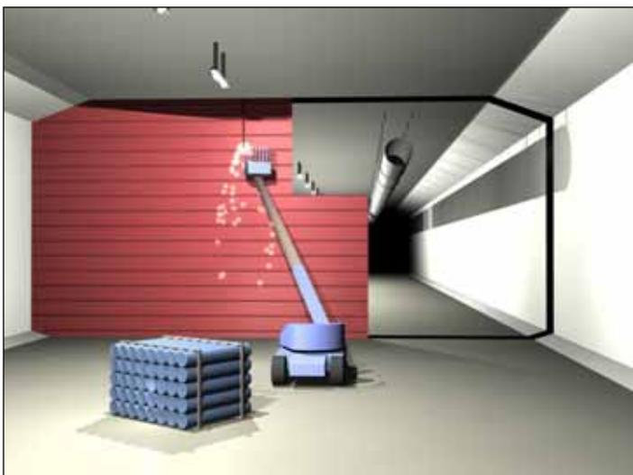
止水壁の役割を果たしたバルクヘッドを小割に切断し、順次撤去します。
