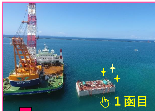
ケーソン1函目据付
