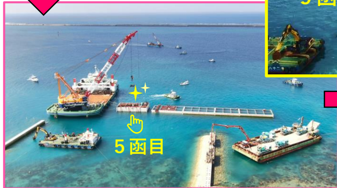
ケーソン5 函目据付
