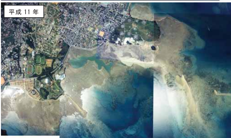
図 3.1.1(2) 泡瀬地区の航空写真
