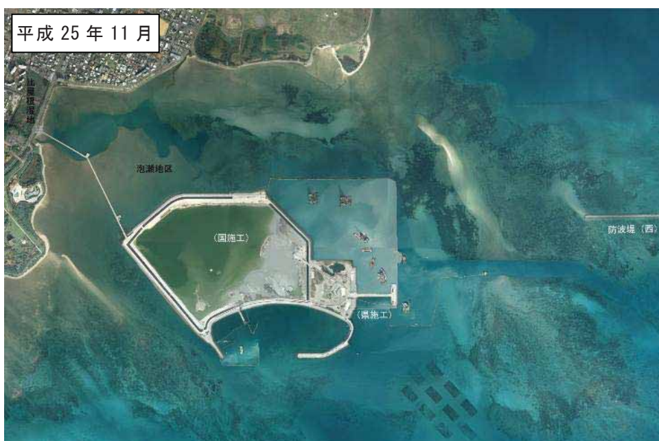
図 3.1.1(6) 泡瀬地区の航空写真
