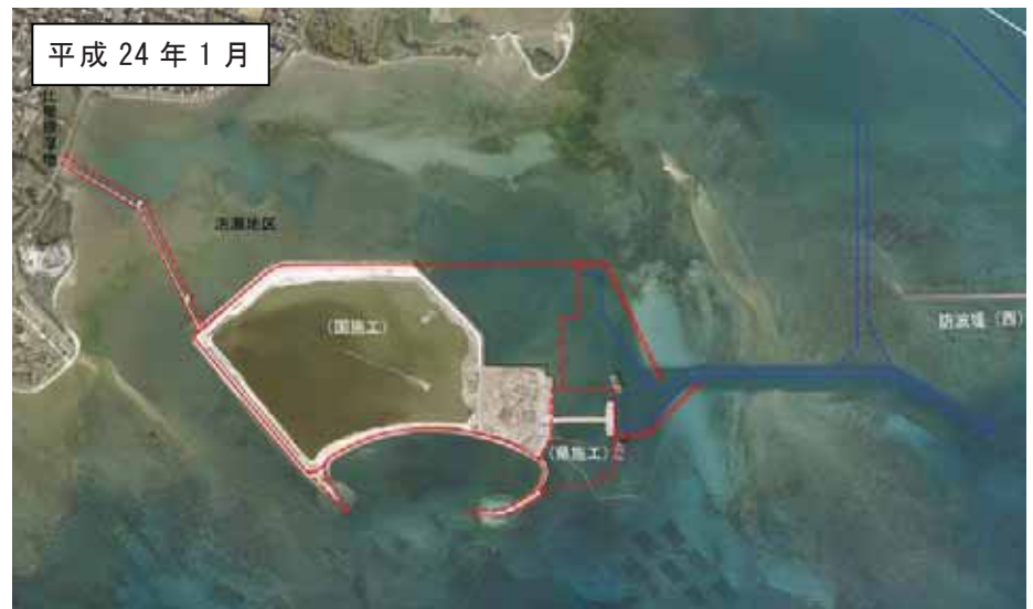
図 3.1.1(5) 泡瀬地区の航空写真
