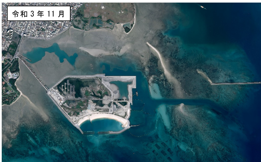
図 3.1.1(8) 泡瀬地区の航空写真
