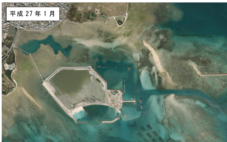
図 3.1.1(6) 泡瀬地区の航空写真
