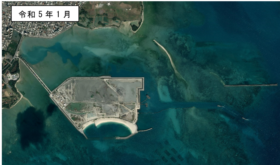
図 3.1.1(9) 泡瀬地区の航空写真
