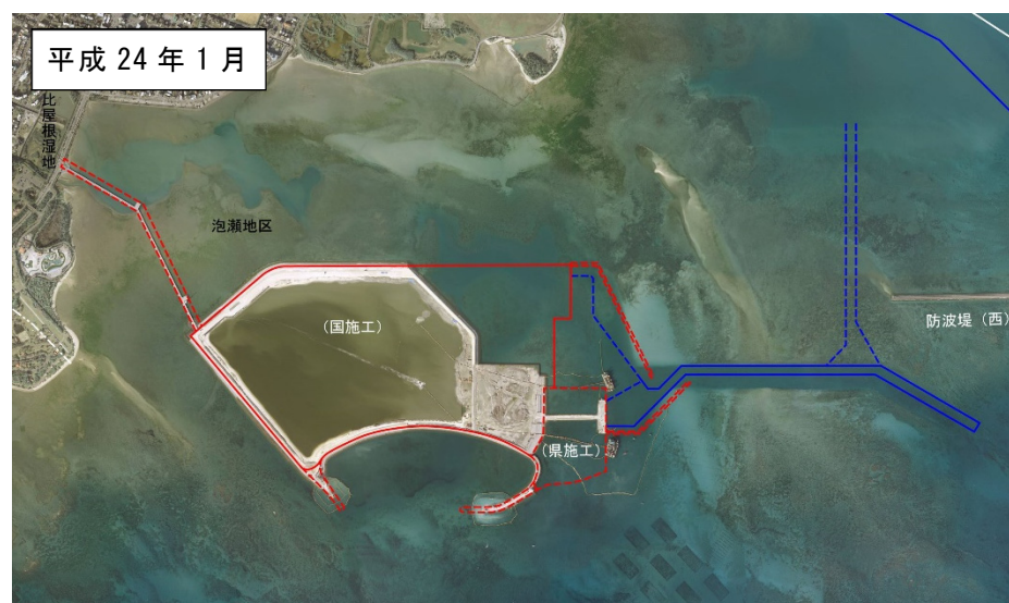
図 3.1.1(5) 泡瀬地区の航空写真
