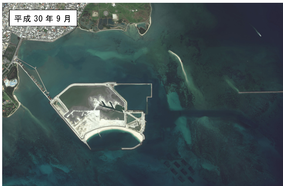
図 3.1.1(7) 泡瀬地区の航空写真
