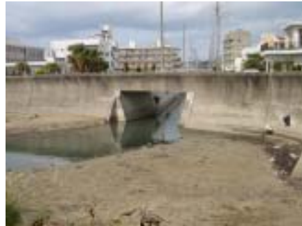
写真7 流入排水路からの汚濁負荷対策は、海域環境を保全するための緊急課題である。
