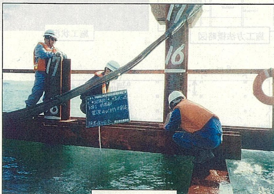
基礎杭打設状況 2
