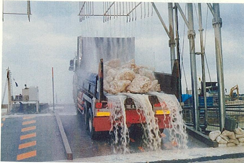
石材洗浄状況
