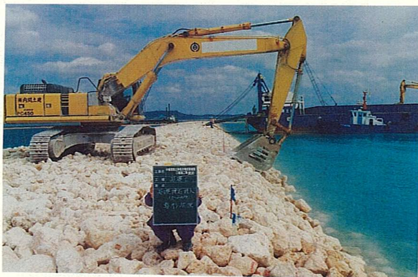
基礎捨石整形状況
