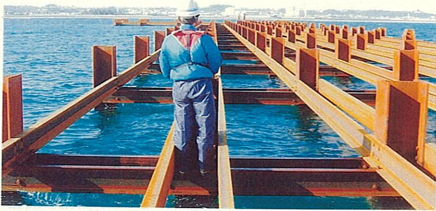
仮設棧橋本體工（H形鋼杭）
