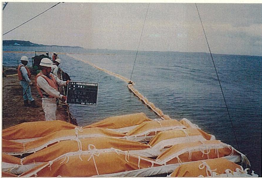
汚濁防止膜設置状況 2
