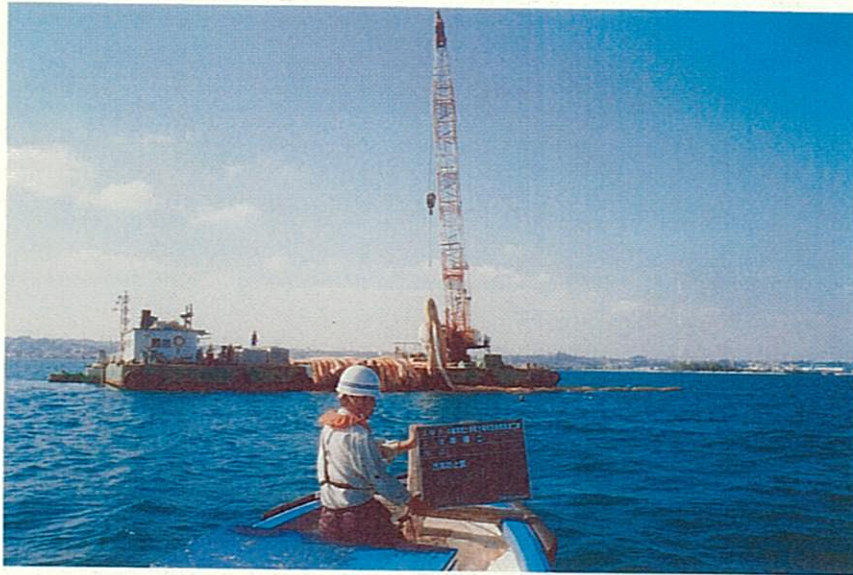
汚濁防止膜設置状況 1
