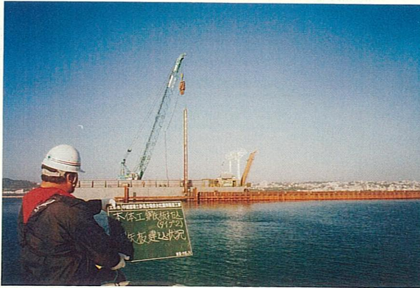
鋼矢板打設状況
