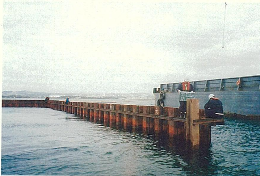
鋼矢板打設済状況
