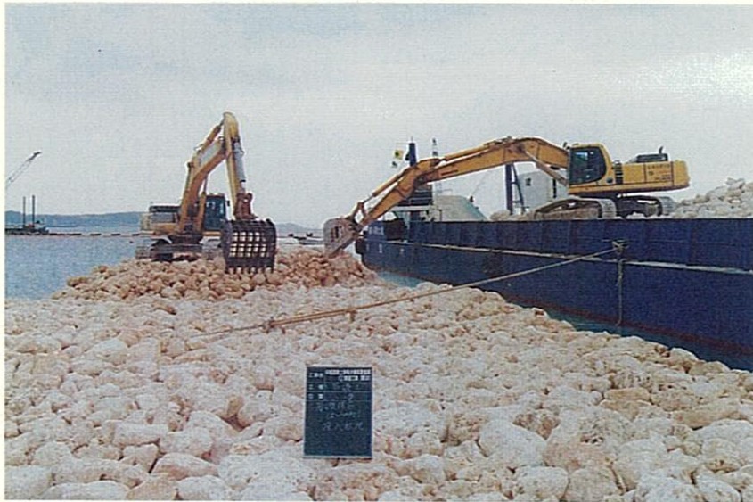
基礎捨石投入状況
