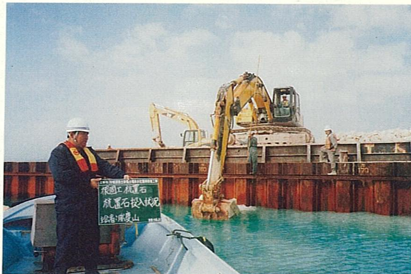
杭置石投入状況
