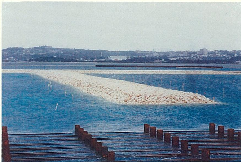
仮設棧橋及び仮設道路
