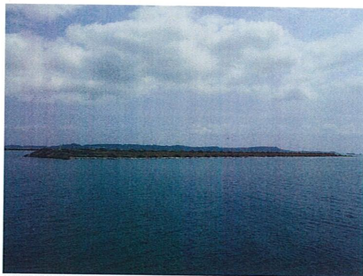
平成16年度C護岸完成
