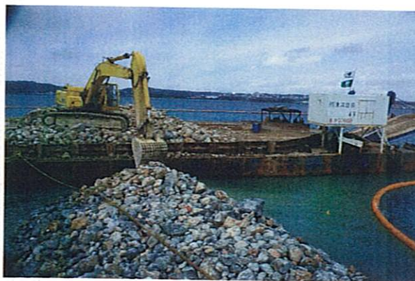
捨石投入状況(オレンジバケット使用)
