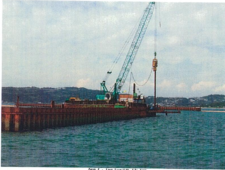
鋼矢板打設状況
