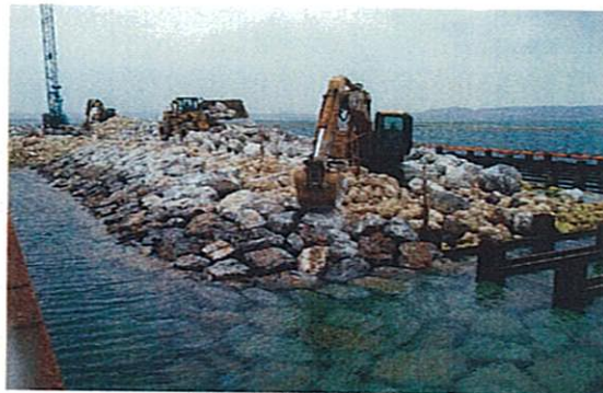
被覆石投入状況
