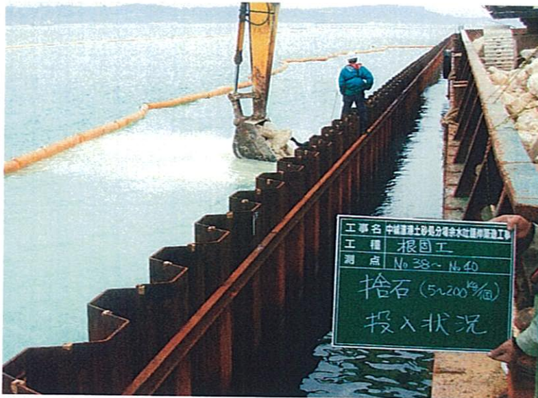
杭置石投入状況
