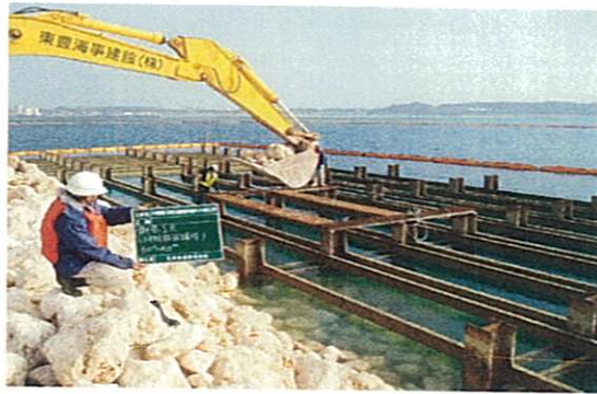
基礎捨石投入状況
