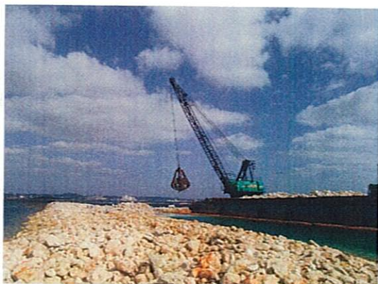
捨石投入状況(オレンジバケット使用)
