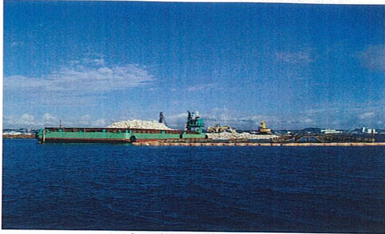
仮設棧橋施工状況
