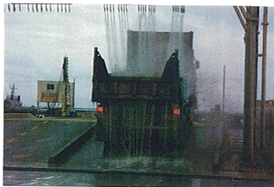
石材洗浄状況
