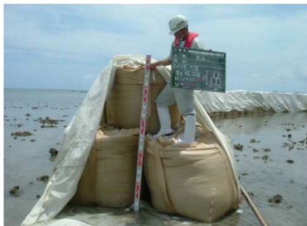
土嚢汚濁防止膜設置
