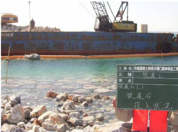
被覆石投入状況
