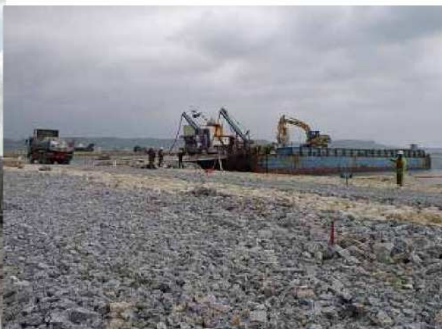
現場にて石材運搬状況
