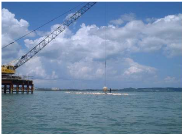
土嚢汚濁防止膜設置
