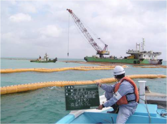
汚濁防止膜設置状況
