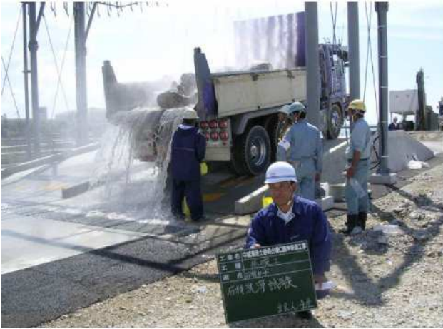
石材洗浄状況
