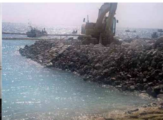
石材均し状況
