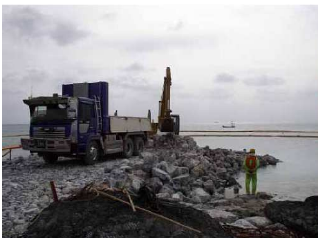
石材投入状況
