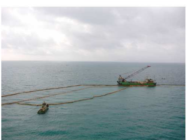
汚濁防止膜設置状況
