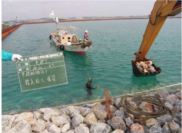
捨石投入状況
