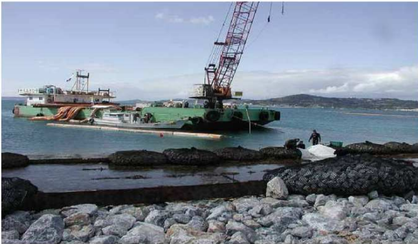
汚濁防止膜設置状況
