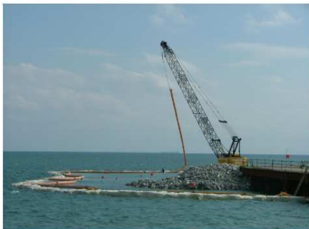
土嚢汚濁防止膜設置
