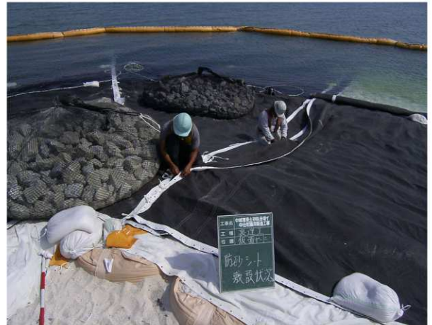
防砂シート設置状況
