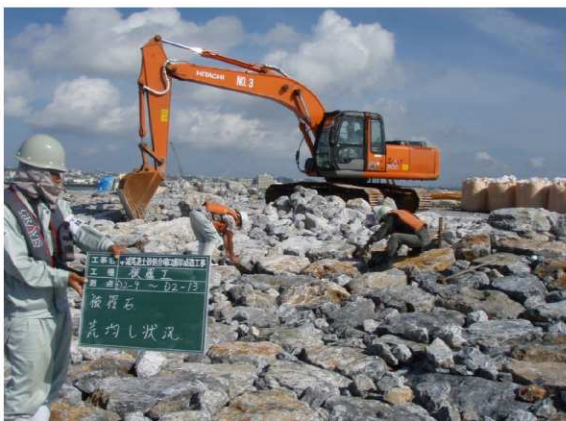
【 石材均し陸上 】
