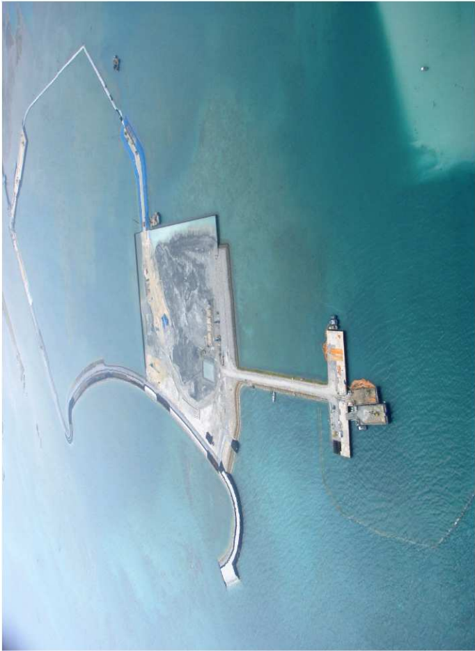
【 ①施工全景 】
