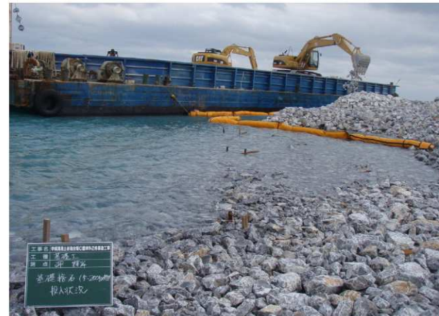
【 石材投入状況 】
