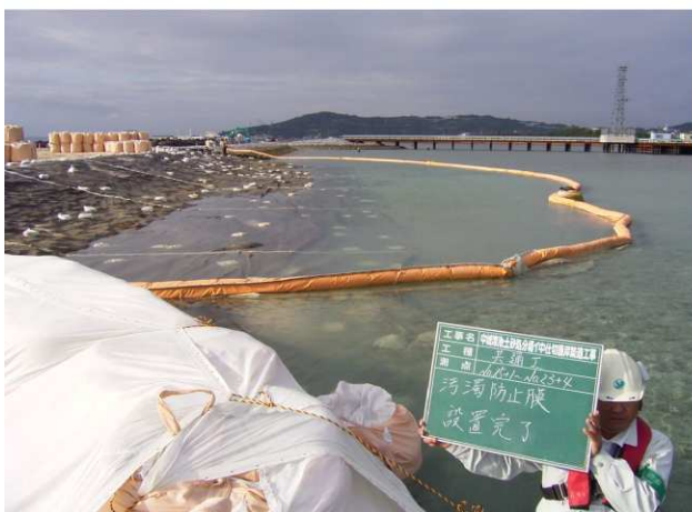
【 水質汚濁防止膜設置状況 】
