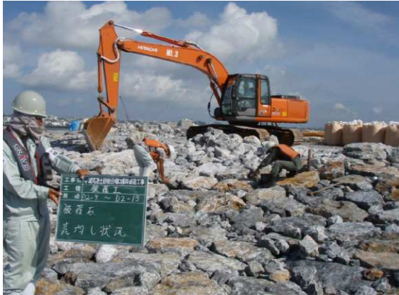
【 石材均し陸上 】
