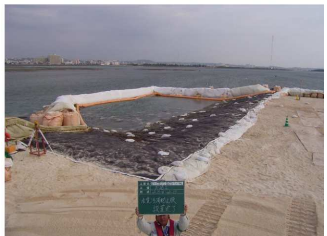
【 土のう型水質汚濁防止膜設置状況 】
