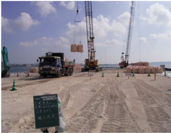
【 大型土嚢設置状況 】
