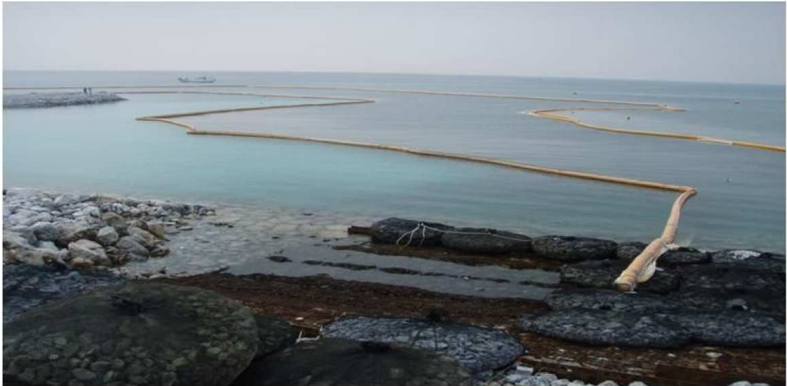
汚濁防止膜設置完了
