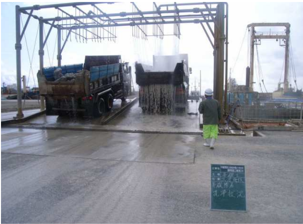
【 石材洗浄状況 】
