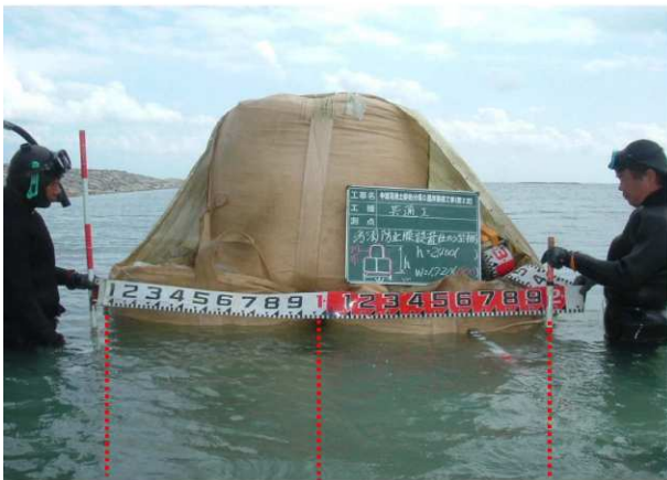
【 土嚢汚濁防止膜設置 】
