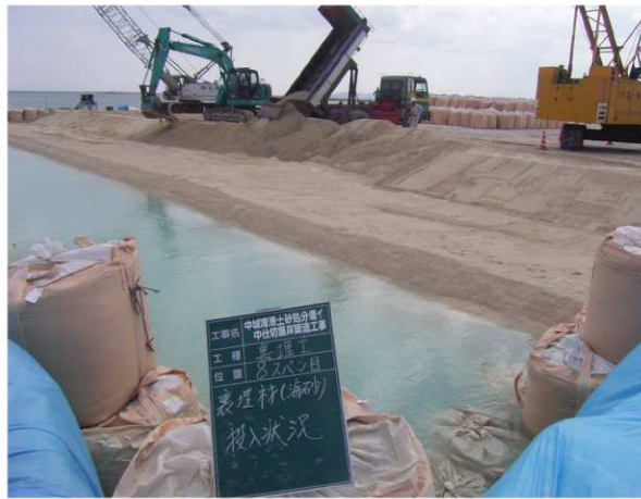
裏埋材投入状況
