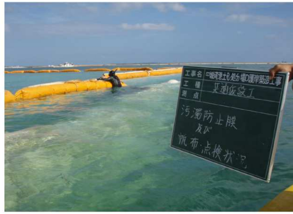
【 土嚢汚濁防止膜点検 】
