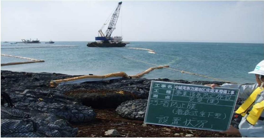
平成19年度汚濁防止膜設置状況
