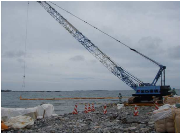
【 土嚢汚濁防止膜設置 】
