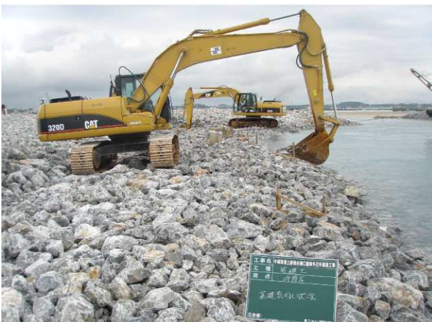
【 石材均し状況(陸上部) 】
