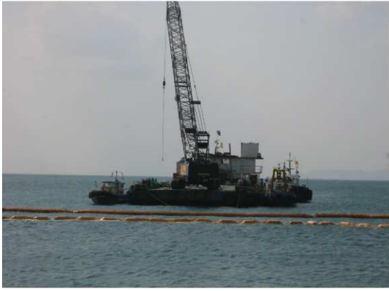
水質汚濁防止膜設置状況
