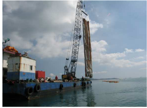
水質汚濁防止膜設置状況
