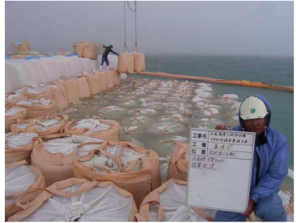
【 大型土嚢設置状況 】
