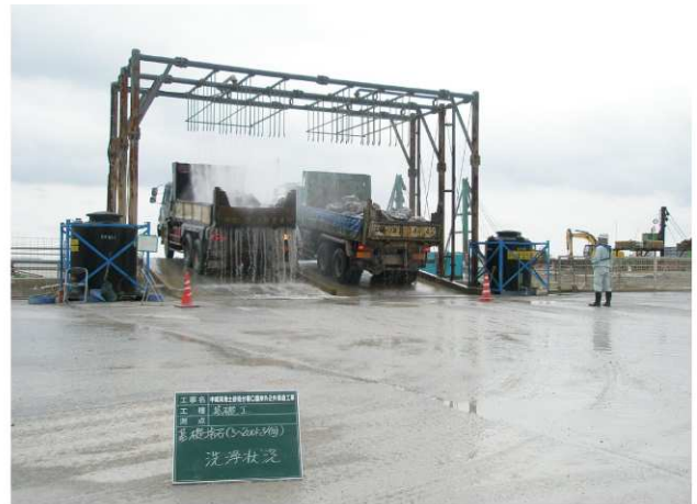
【 石材洗浄状況 】
