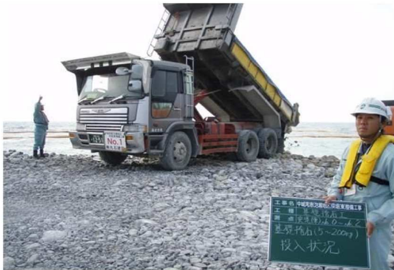
石材投入状況
