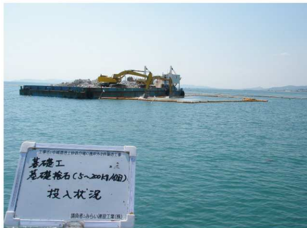
【 石材投入状況 】
