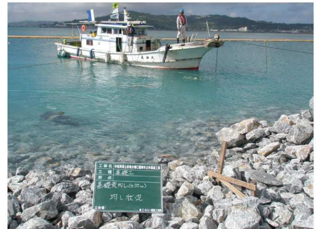
【 石材均し状況(水中部) 】
