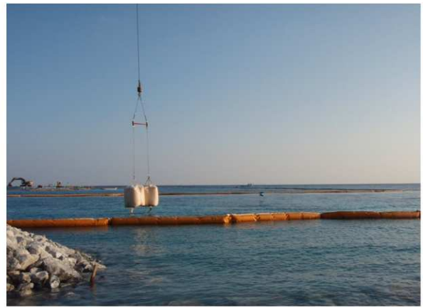
【 土嚢汚濁防止膜設置 】
