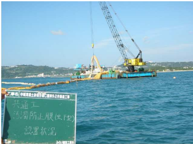
【 水質汚濁防止膜設置状況 】
