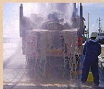
石材の洗浄の様子
