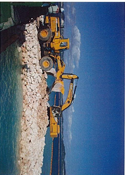
7. 石材投入(トラクターショベル)
