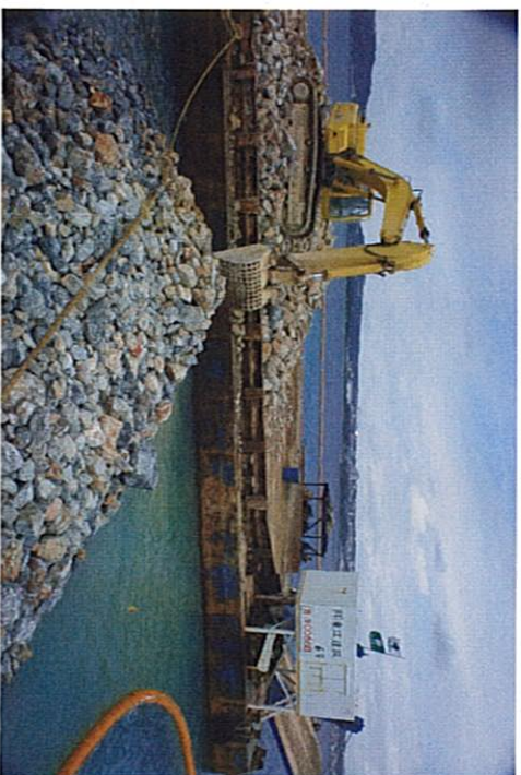
5. 石材投入(スチルトンバット)
