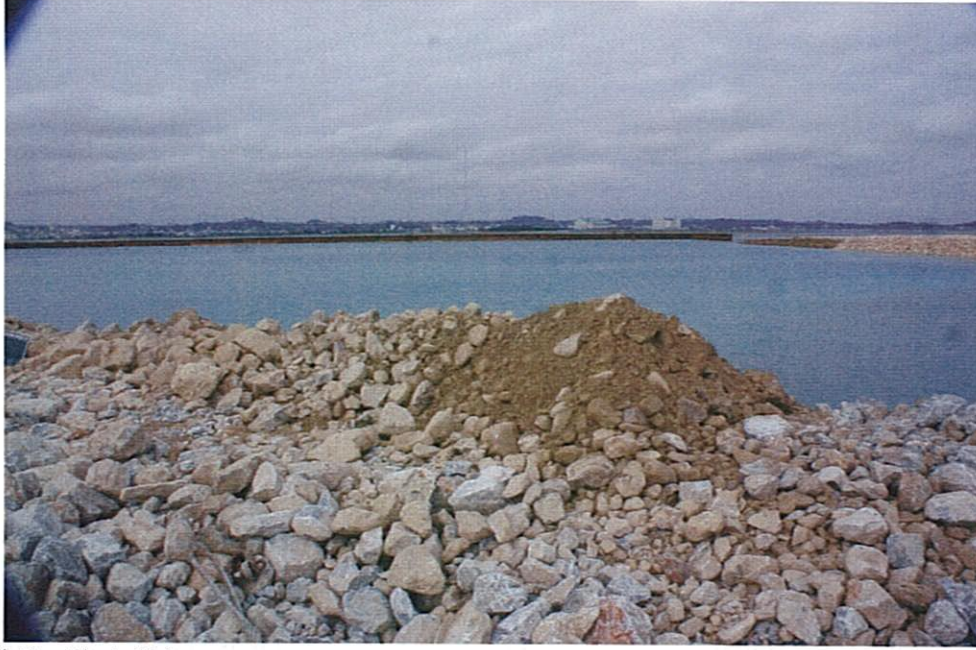
④⑤C護岸 除去状況
