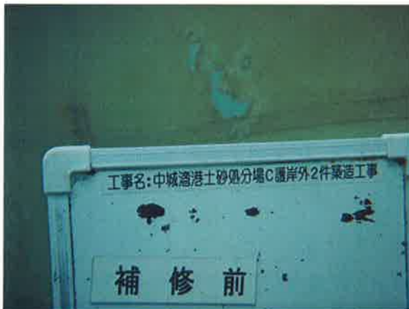
②汚濁防止膜破損確認
