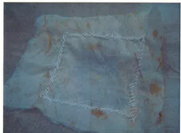
④汚濁防止膜補修完了
