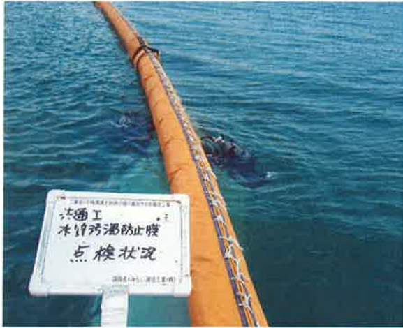
①汚濁防止膜点検状況
