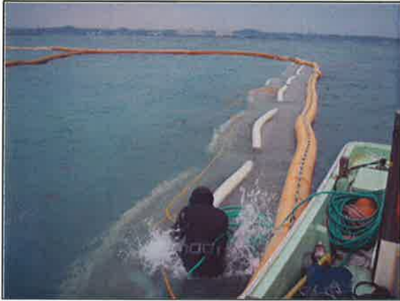
①汚濁防止膜点検状況
