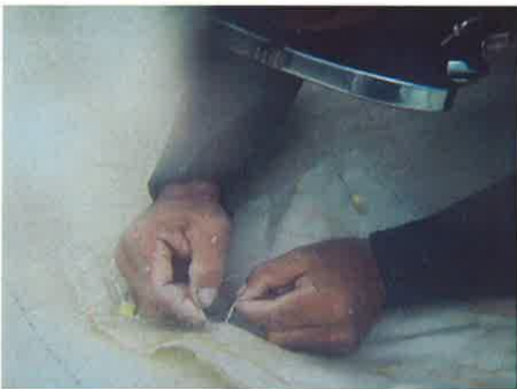
③汚濁防止膜補修状況
