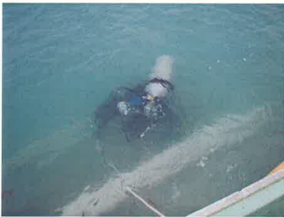
①汚濁防止膜点検状況
