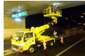
トンネル点検車
