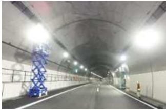
不灯箇所機器点検や灯具の取替え
