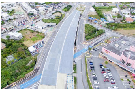
南風原バイパス 令和3年10月18日撮影
