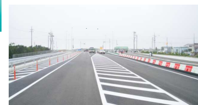
読谷道路 平成 25 年度 開通区間
