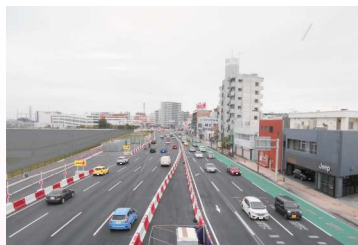
浦添拡幅 令和3年度暫定8車線開通
