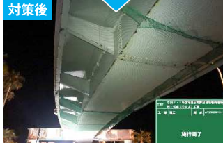
落下防止ネットの設置
