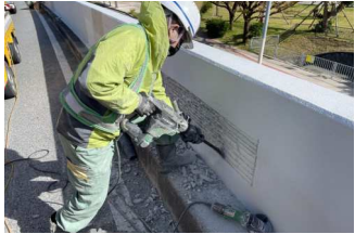
高架橋高欄補修
