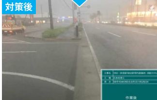
大雨による冠水被害の応急処理
