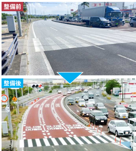
ドットライン、路面表示、カラー舗装（北谷町北谷交差点）
