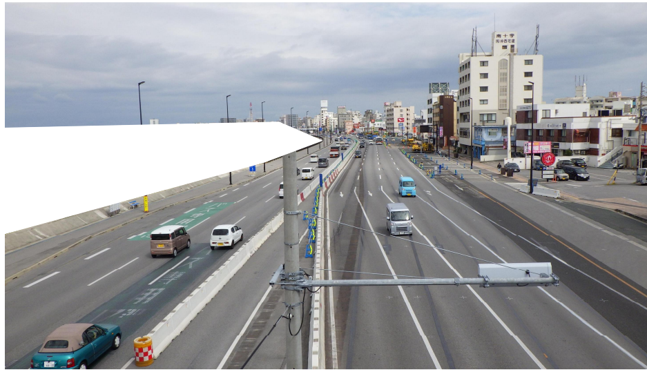
撮影箇所③ 国道58号宮城交差点北向け
