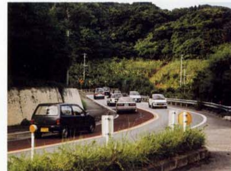
道路線形が悪く狭小幅員のため危険！
