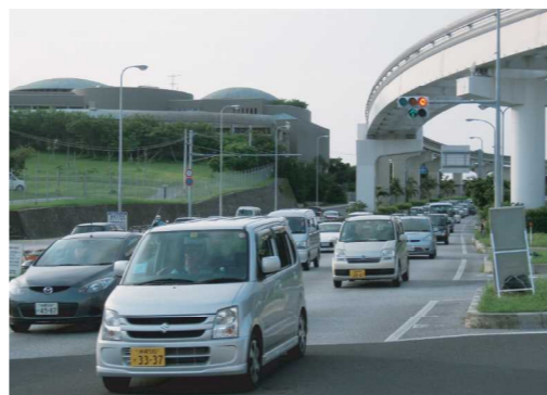
② 国道331号赤嶺交差点付近
