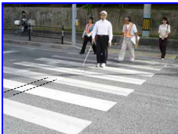
【今までの構造】 ・エスコートゾーンが設置されているが横断歩道に同化。 ・弱視者にとってわかりにくい。(印刷団地前)
