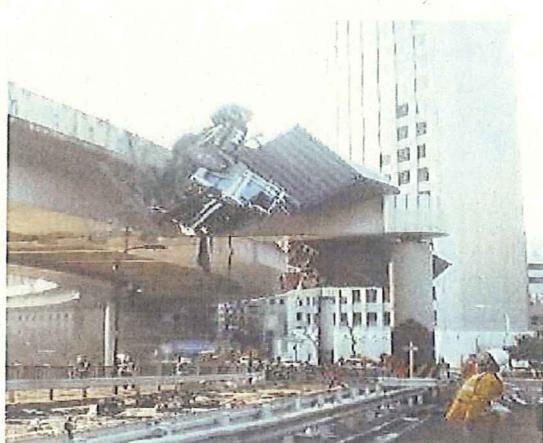
高欄を越え横転し、橋脚の横梁上に車両が落下。
