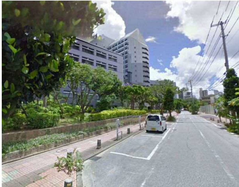
整備前(パーキングメーター)
