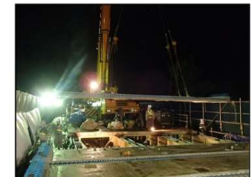
(新しいコンクリート床版の設置状況)
