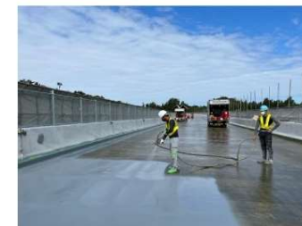
(床版防水工事)
