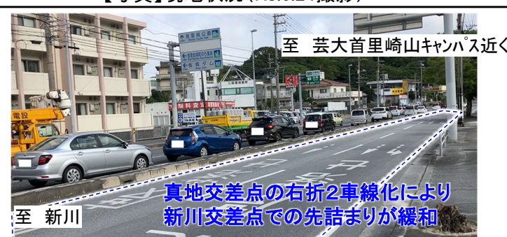
【写真】現地状況(R8.6.24撮影)
