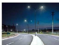
LED照明 (消費電力約56%削減)
