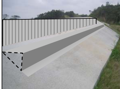
写真 3.8 F 直壁構造(張りコン部)
