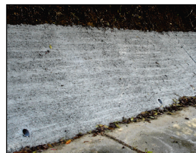
写真 3.2.2 粗面仕上げ例(県道 70 号線)
