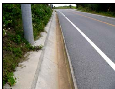
写真 3.6 D 側溝 (片側緩傾斜)
