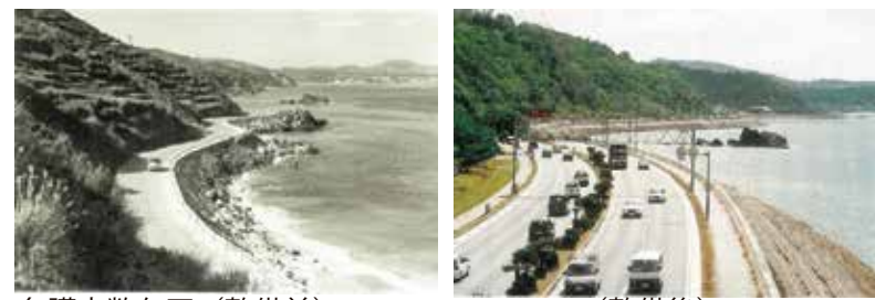
名護市数久田 (整備前) (整備後)
