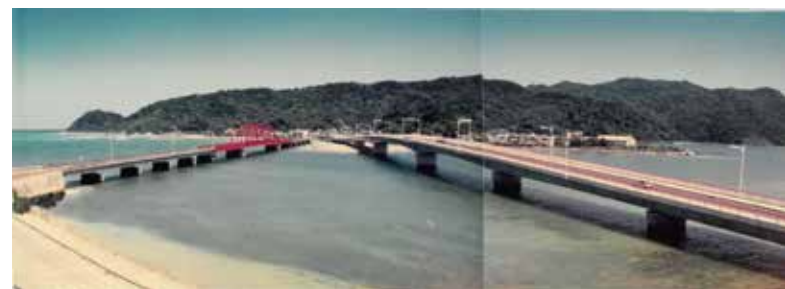
大宜味拡幅(左:旧塩屋大橋 右:塩屋大橋)
