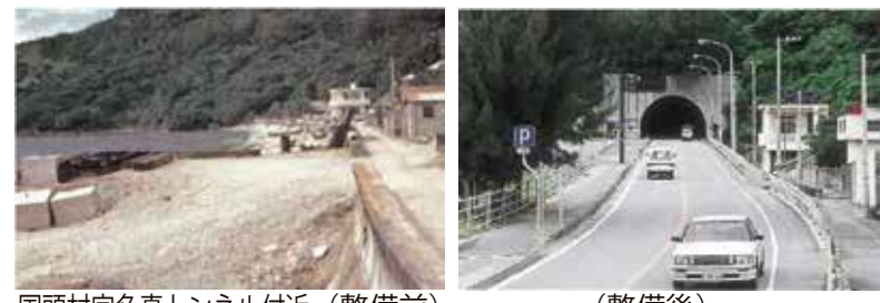
国頭村宜名真トンネル付近 (整備前) (整備後)
