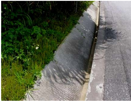
全面片側緩傾斜側溝（国道 58 号）
