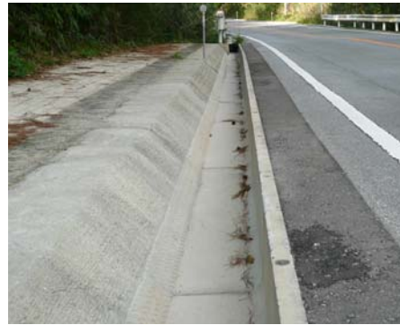
全面片側緩傾斜側溝（県道 70 号線）
