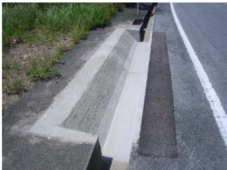
部分片側緩傾斜側溝（県道 70 号線）
