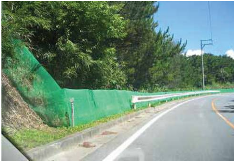
写真 クイナフェンス設置状況
