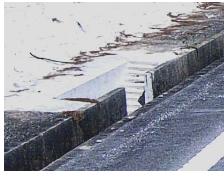
スロープ付き側溝（県道 70 号線）
