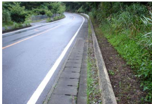
写真 草刈り状況（国道58号）
