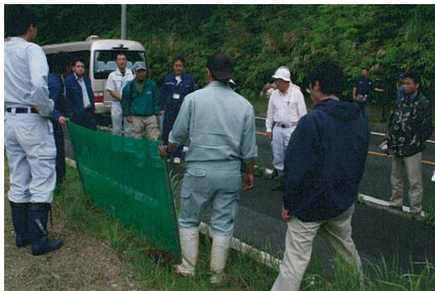
【クイナフェンス設置作業の様子为例】
