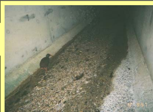
【道路下横断路の内部】
