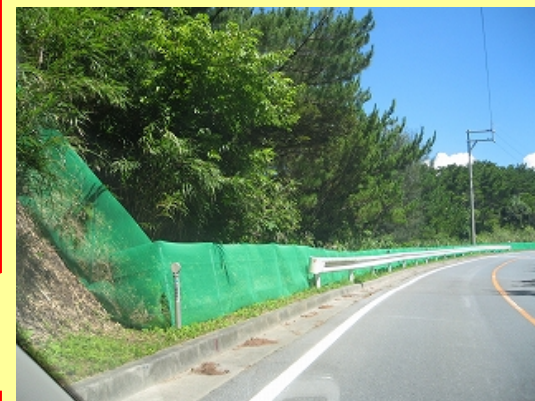
【クイナフェンスの設置】
